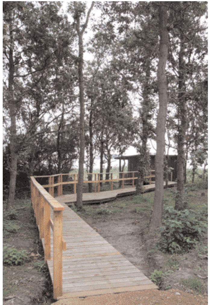
Handicapvenlig rampe til det nye fugleskjul ved Bøjden Nor. Foto: Allan Gudio Nielsen
