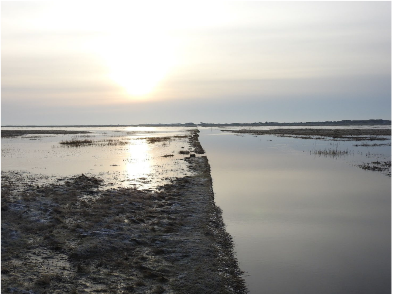
Ved vestenstorme og særlige højvande bliver Skomagersletten samt vejen oversvømmet, 11.12.2017.
