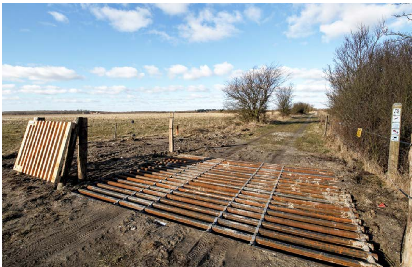
Fem nye færister er også en del af projektet. De skal forhindre, at dyrene løber ud på markveje i området. Foto: Rasmus Romme.
