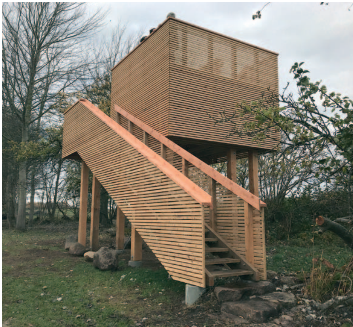
Det nye tårn i Gulstav Mose, 15. november 2018. Foto: Esben Eriksen
