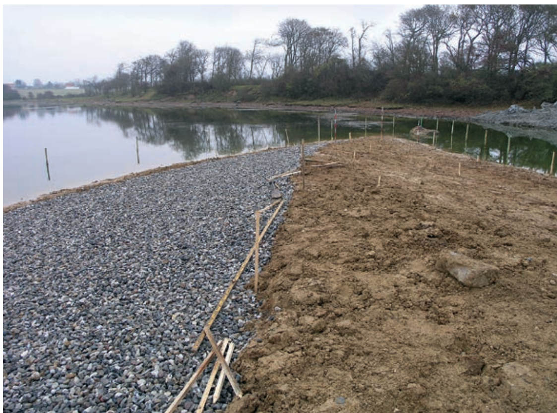
En fugleø under opbygning i Bøjden Nor. For at forhindre uønsket opvækst af høje urter, er der som bund brugt moræneler uden næringsstoffer. Mod havsiden er lagt sten, der skal forhindre erosion af øen. Foto: Helle Hjorth
