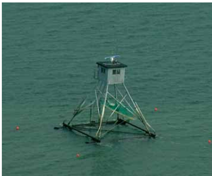
DMUs radar- og observations-tårn brugt under dataindsamlingen ved Nysted Havvindmøllepark. Foto: Jonas Teilmann/DMU.
