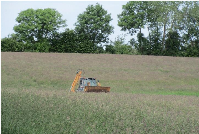
10. juni 2020. Alle buske og rør fjernes maskinelt.
