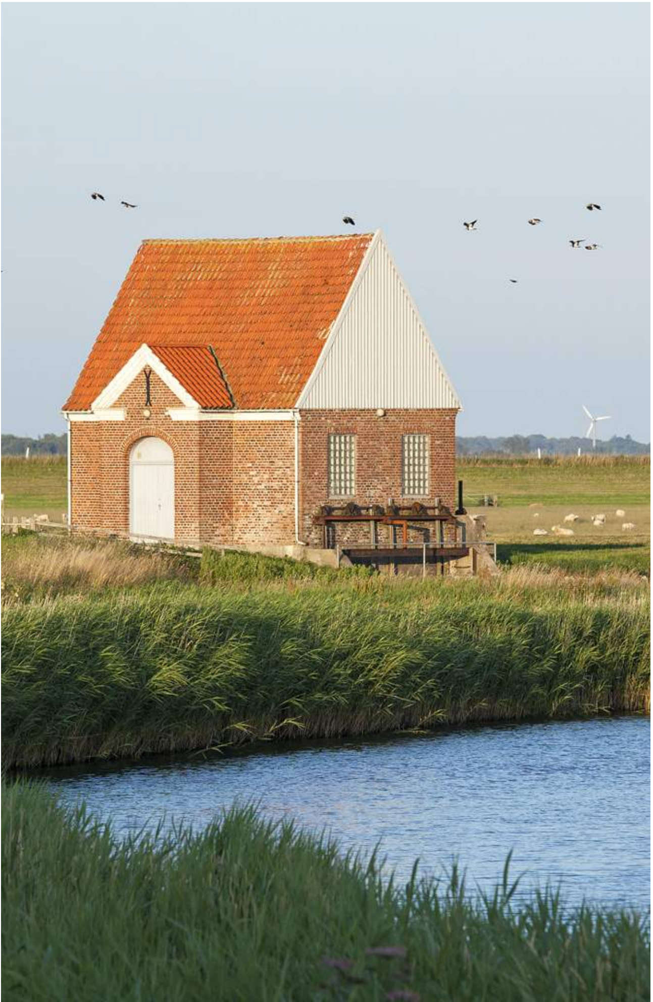
Pumpestation ved Vidåen i Tøndermarsken, IBA nr. 60. Foto: Kurt Rodahl Hoppe
